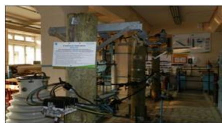
Лаборатория высоковольтного оборудования
